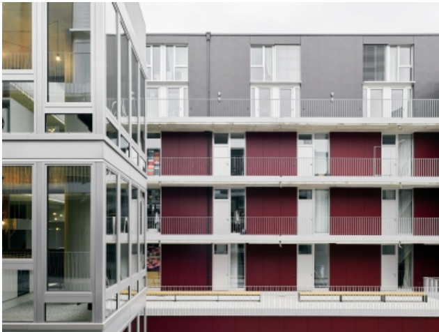
Die Wohnungen der Überbauung MIN MAX sind über Laubengänge erschlossen.
