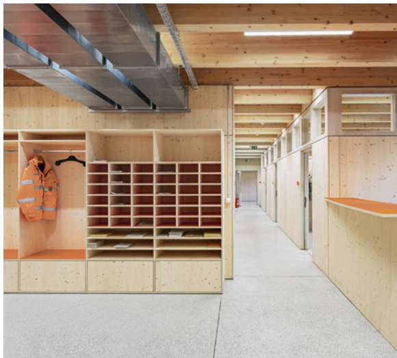
Empfang, Garderoben, Ablagefächer – alle Einbauten wurden in Fichtenholz erstellt.
