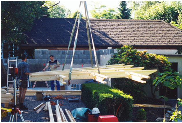
Levage de la grille de support
