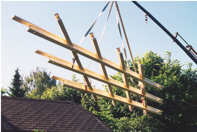
Déchargement de la grille de support
