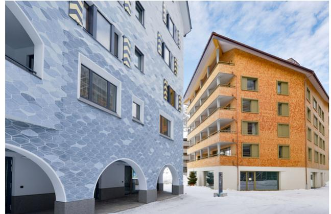
Zurzeit gibt es noch keine Grundlagen zum Stand der Technik für Schindelfassaden, die die Konstruktionsgrundsätze für den Brandschutz festhalten. Brandversuche ermöglichten die über sechs Geschosse durchlaufende Schindelfassade beim Apartmenthaus Wolf.
