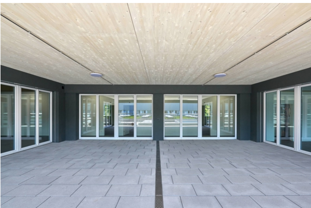
Eingangsbereich mit Holz Decke
