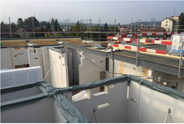
Einbau des unterspannten Unterzugs
