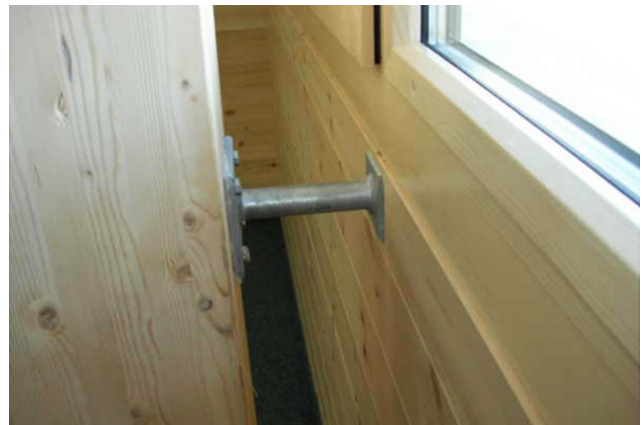
Detail Unterstützung - Fassade
