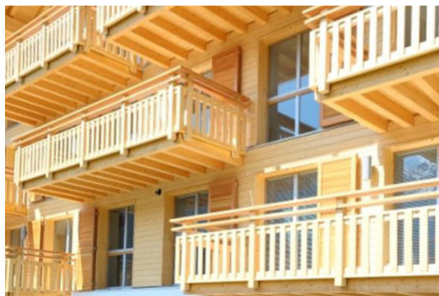
Fassade mit Balkonen, Foto Wenger Fenster Wimmis
