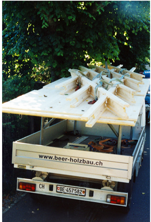
Anlieferung zusammengeklappter Trägerrost
