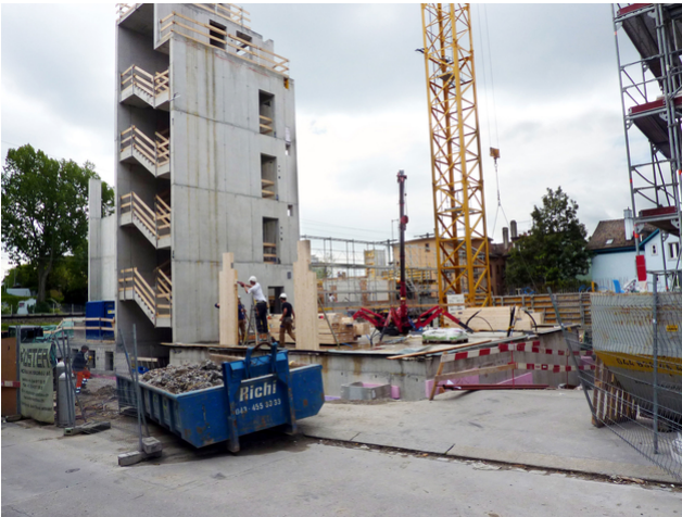
Start Stützenmontage EG
