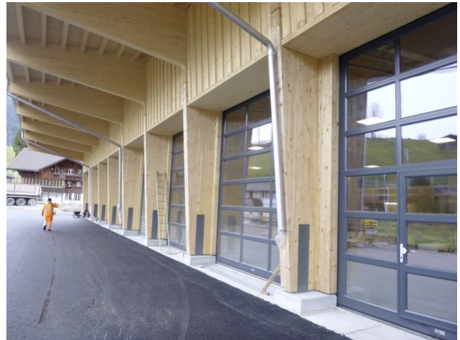
Der Bau ist fast nur aus hiesigem Holz und trägt das Herkunftszeichen Schweizer Holz (HSH)
