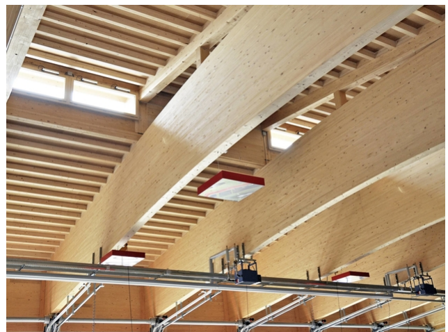
Detailaufnahme der grossen und schweren Holz-Bogenbinder
