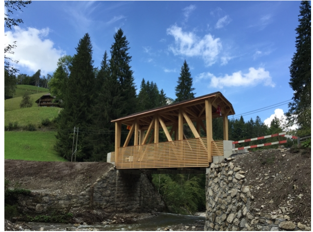
Statt einer Betonbrücke gibt es eine Neue Holzbrücke im Berner Wald
