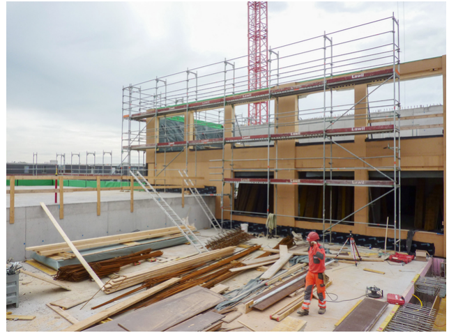
Holzelemente für die neue Schulanlage im Bau
