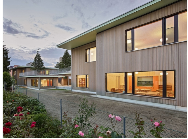
Der neue Kindergartenkomplex besteht aus mehreren Holzhäusern (Fotos: Zeljko Gataric)
