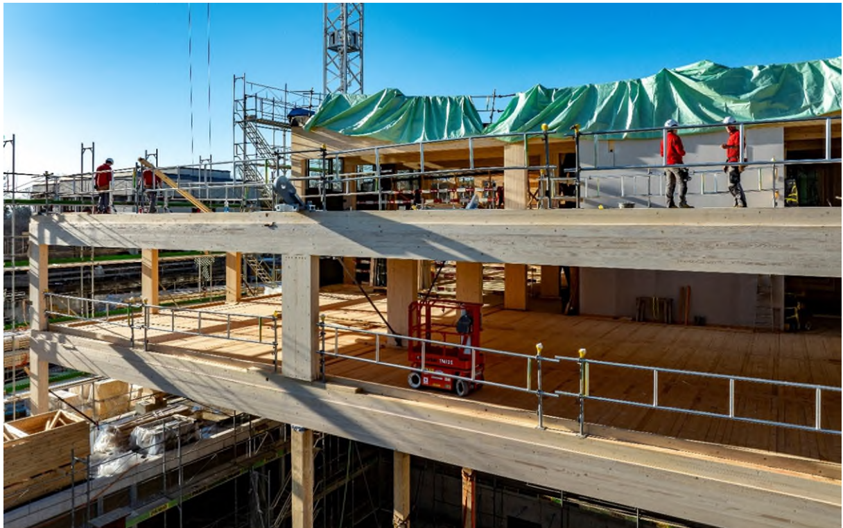
Abb. 6: Blick auf das Tragwerk mit den erforderlichen Zuggliedern aus Stahl, den Knotenpunkten und den aufgehängten Holzstützen an das Stahlelement, Foto: Busslinger Fotografie
