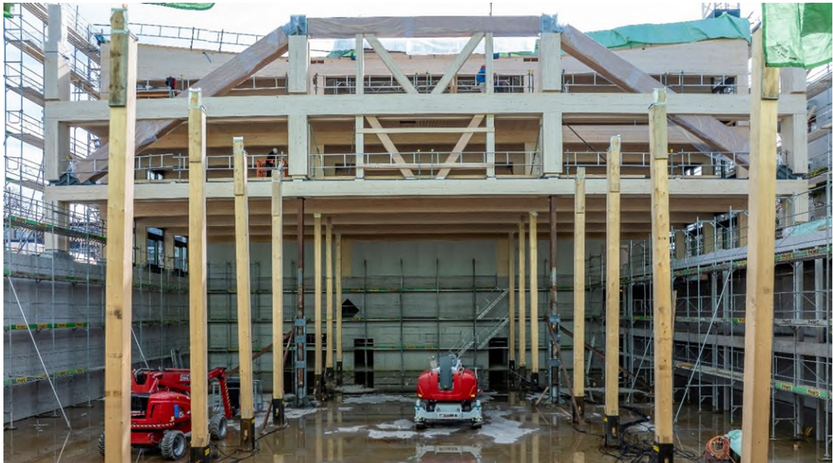
Abb. 3: Ansicht des primären Raumfachwerkes, dass technisch ein Hängesprengwerk mit innenliegend Fachwerk ist, während der Errichtung mit temporärer Abspriessung. Foto: Busslinger Fotografie
