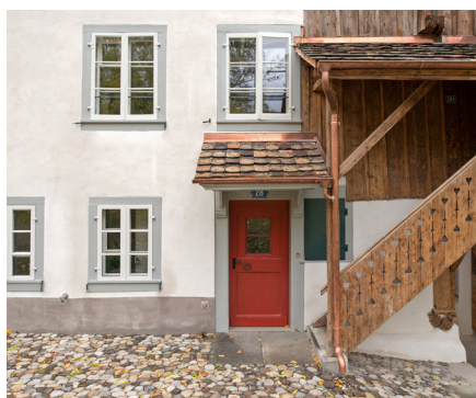
Eingangsbereich saniertes Doppelwohnhaus
