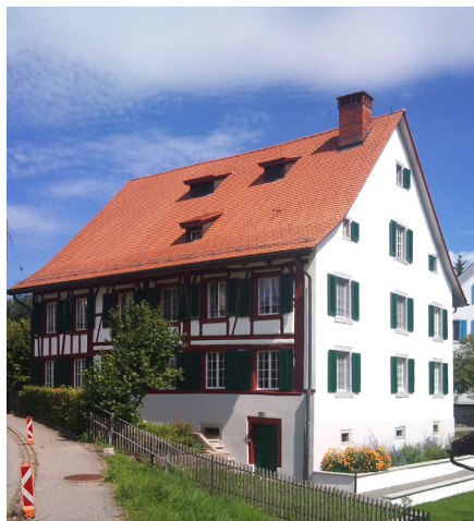
Sanierung Pfarrhaus, Maschwanden
