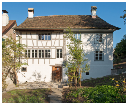
Sanierung Doppelwohnhaus, Zürich
