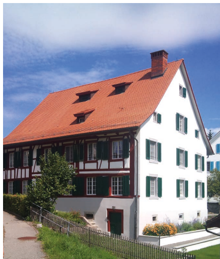
Sanierung Pfarrhaus, Maschwanden
