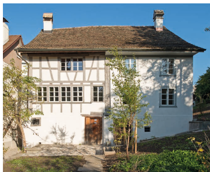
Sanierung Doppelwohnhaus, Zürich
