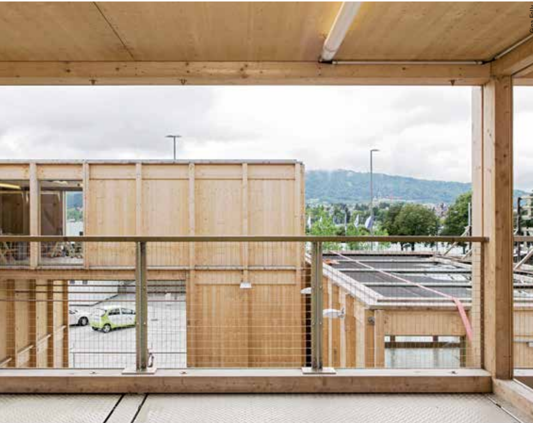
Element Nr. 9 Bodenelement / Deckenelement: Installationen sind frei sichtbar.
