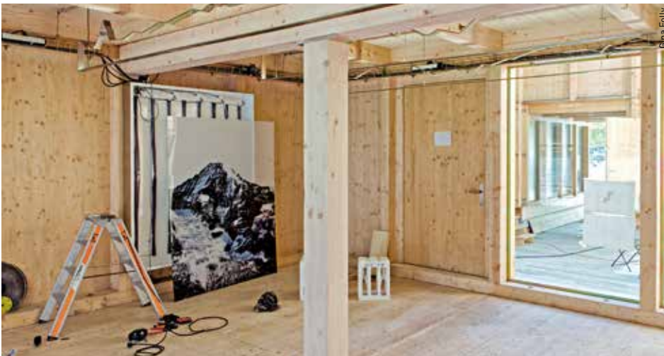
Element Nr. 6 Unterzug mit Stützen. Die Oberflächen bleiben roh belassen.
