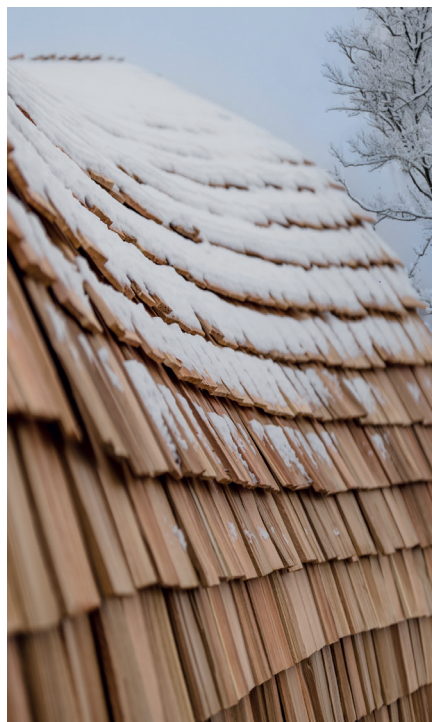
Das Schindeldach und zusätzliche Verstärkungsbögen gewährleisten Standfestigkeit bei Windspitzen von bis zu 160 km/h und Schneelasten von bis zu 8 Metern (800 kg/m 2 ).
