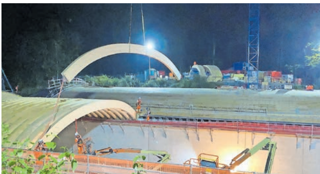
Ungewohnte Situation: Die 156 verleimten und im Aargau produzierten Holzträger wurden alle bei Nacht eingebaut
