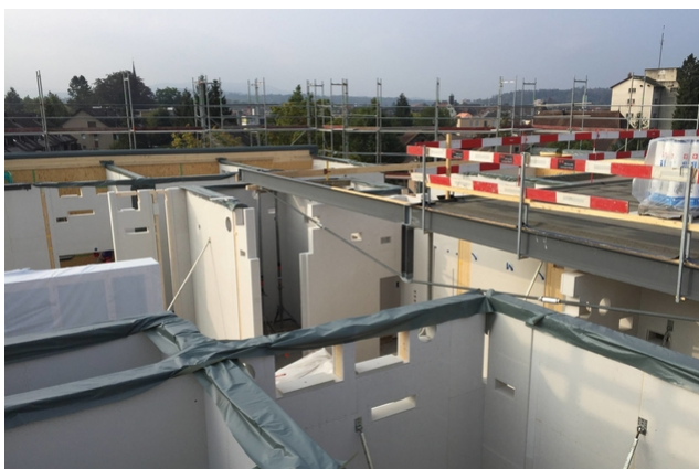
Installation de la poutre sous-tendue
