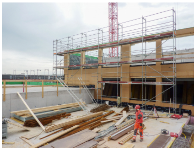
Éléments en bois pour le nouveau complexe scolaire
