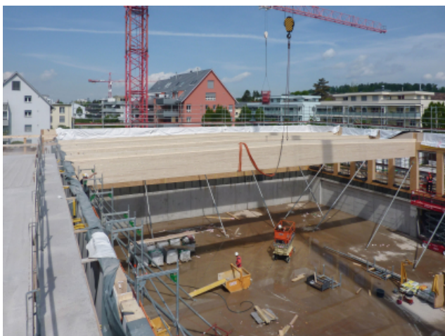
Installation de porteurs de toit pour la nouvelle salle de sport
