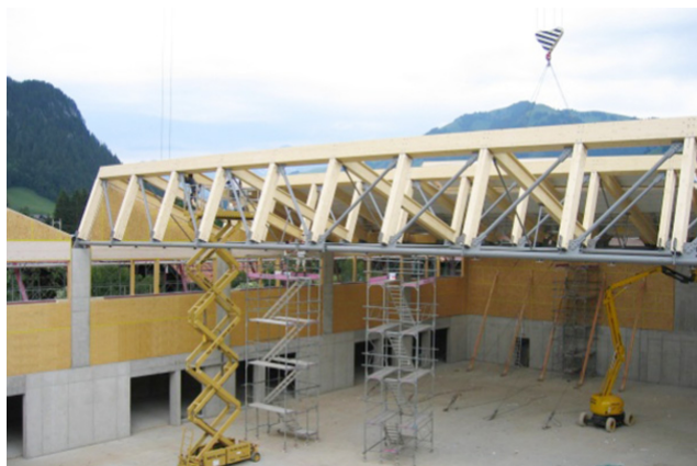
Montage de poutres en treillis
