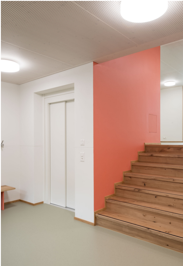
Escaliers avec panneaux en chêne massif
