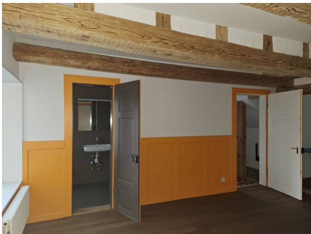
Les plafonds ont été soigneusement rénovés, redonnant ainsi tout leur éclat à certaines parties de la construction existante.
