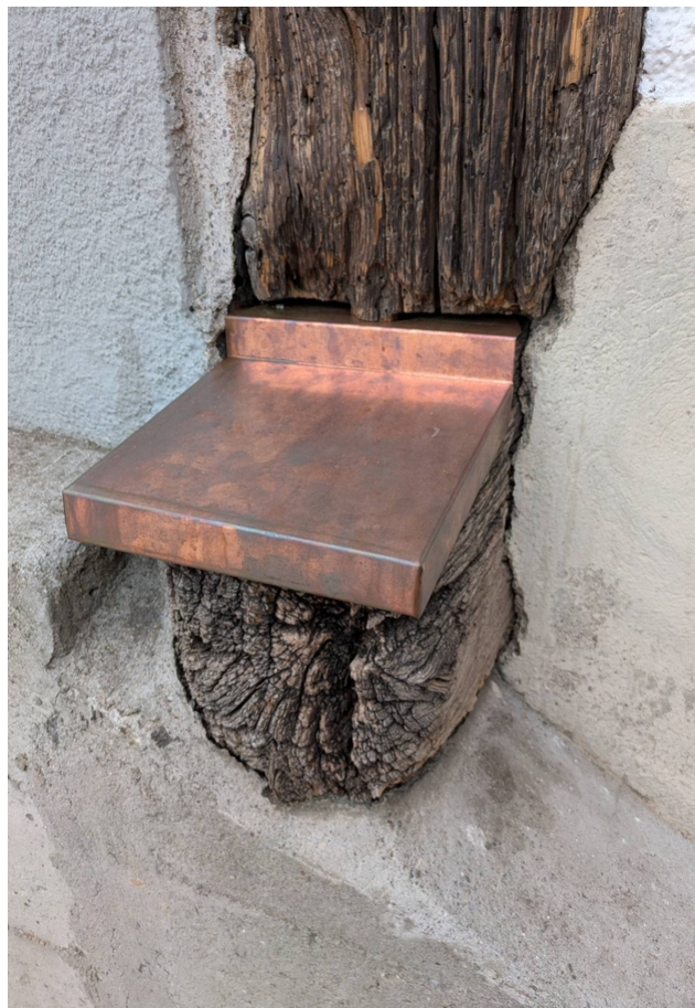
Une protection constructive du bois aide à protéger la charpente contre la pénétration de l'humidité.
