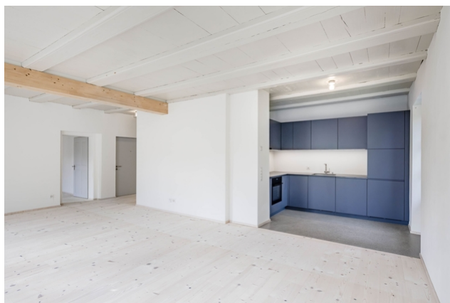
Membrure inférieure apparente de la poutre Vierendeel
