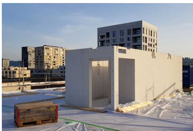
Cage d'escalier en cours de construction
