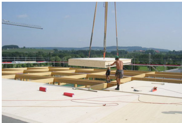
Montage d'éléments de toiture
