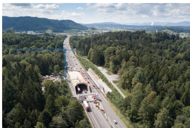
Vue aérienne pendant le montage
