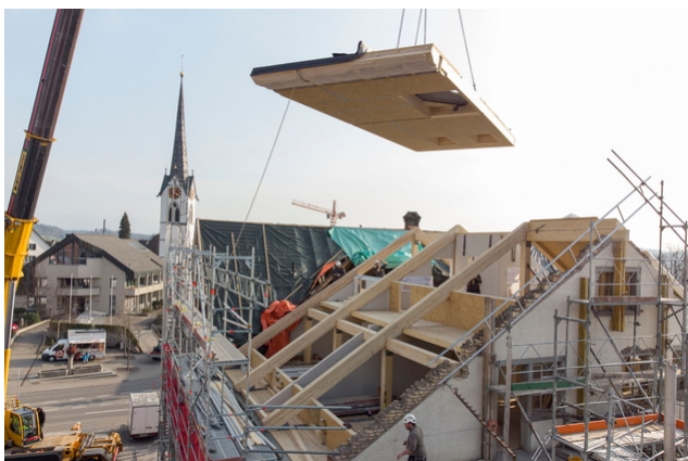
Aménagement des combles avec mise en place de modules préfabriqués
