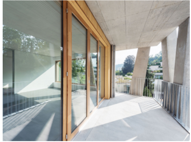
Ci-contre: un bâtiment résidentiel en bois rencontre un porche en béton
