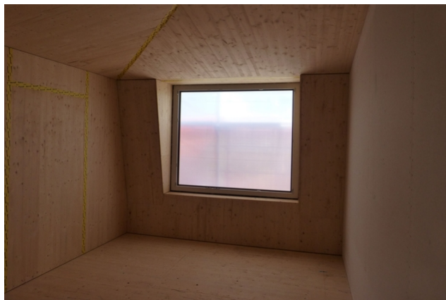
Innenansicht während der Bauphase
