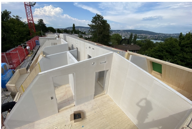
Ansicht direkt in den Elementbau Aufstockung
