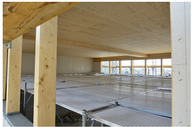
Deckenatrium mit 12m Spannweite
