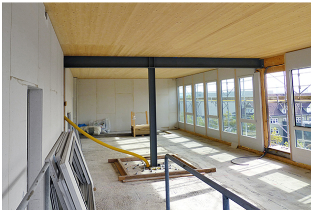
Primäre Stahlkonstruktion
