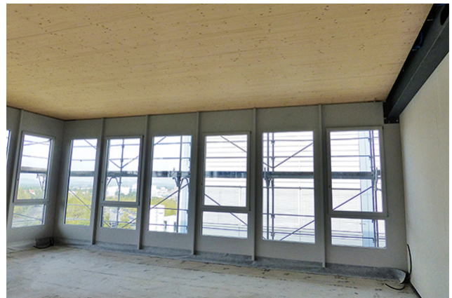
Holzdecke mit 9m Spannweite
