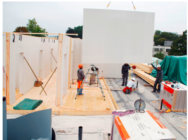
Versetzung Trennwände Aufstockung
