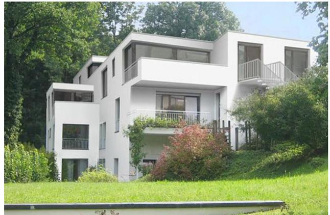
Auf dem bestehenden Zweifamilienhaus in naturnaher Lage wurde durch eine ein- bis zwei- geschossige Aufstockung neuer Wohnraum in Holzrahmenbauweise geschaffen. Besonders sind die unterzugsfreie Flachdachkonstruktion und die raumhohen Glasfronten.
