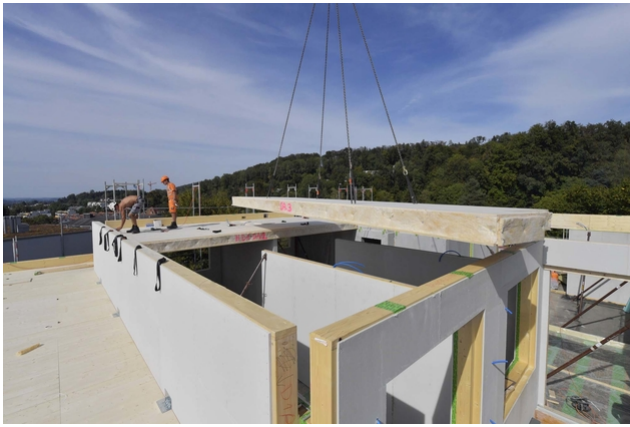
Aufrichtearbeiten mit dem Kran
