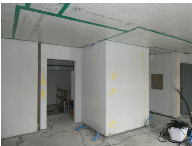
Gekapseltes Treppenhaus in der Bauphase
