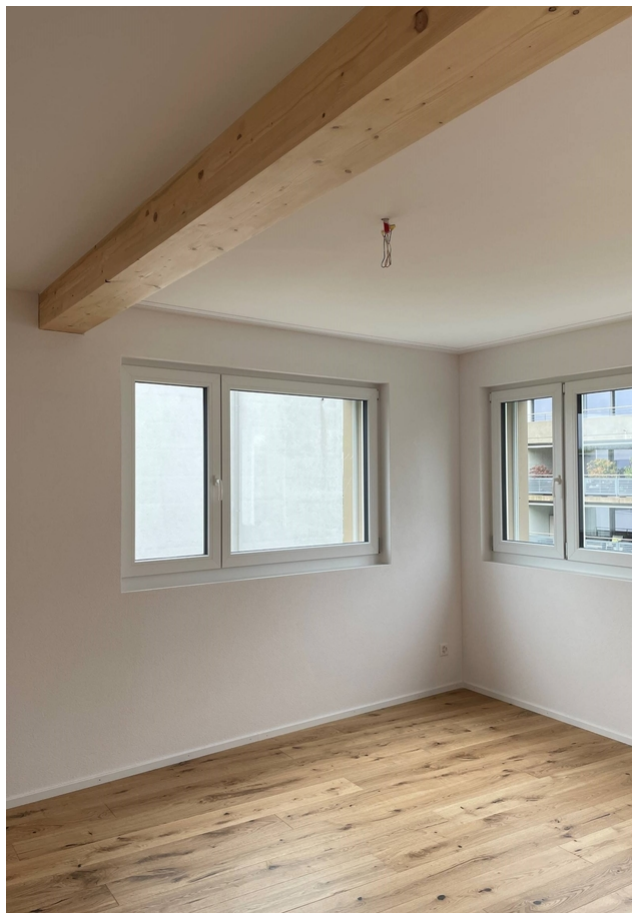
Unterzug aus Brettschichtholz
