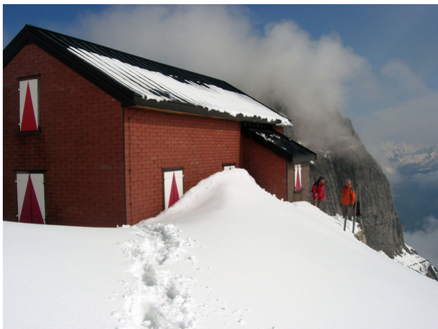
Die ursprüngliche Dossenhütte
