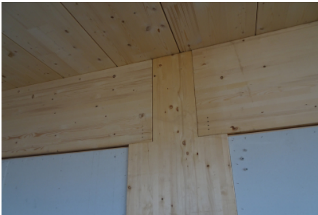
Auflager der Träger auf den Stützen
