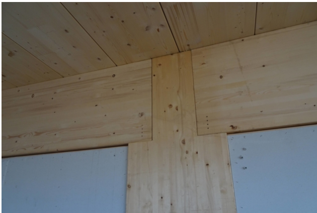
Auflager der Träger auf den Stützen
