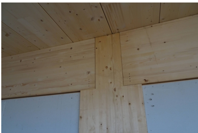
Auflager der Träger auf den Stützen
