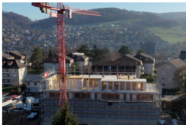
Der Fasanenhof während seiner Erstellung
