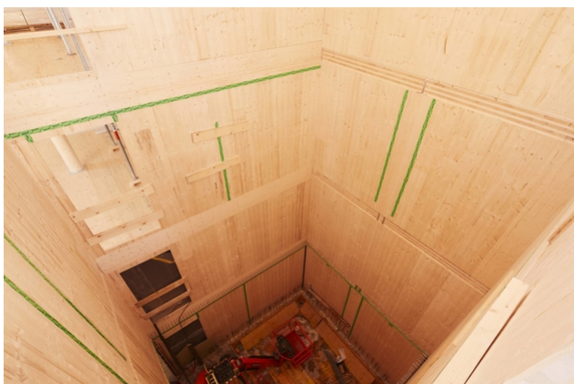
Der Treppenhaukern steht. Der flüssige Beton wird nachträglich eingegossen
