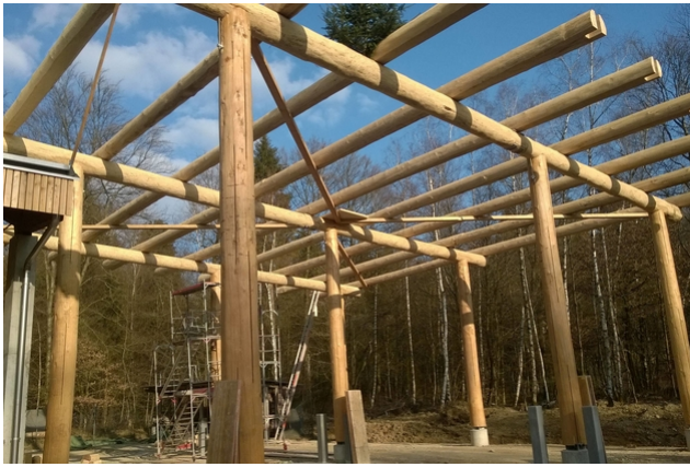
Tragwerk nach Montage
