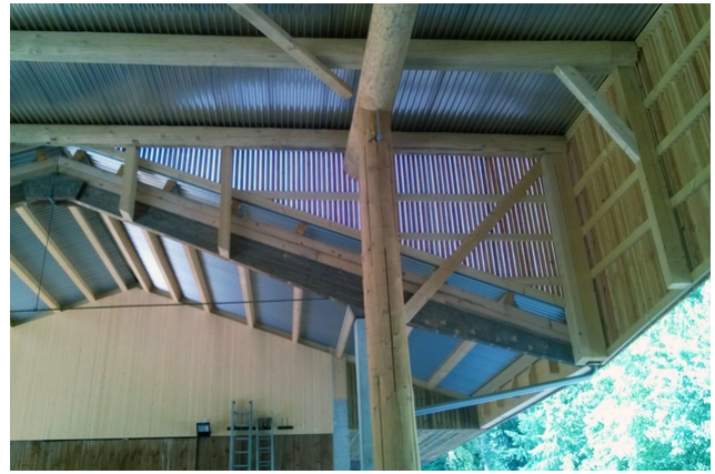
Tragwerk im fertigen Gebäude
