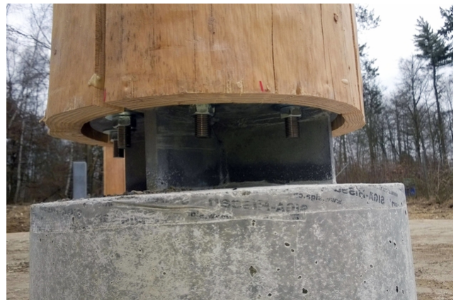
Montierter Stützenfuss
