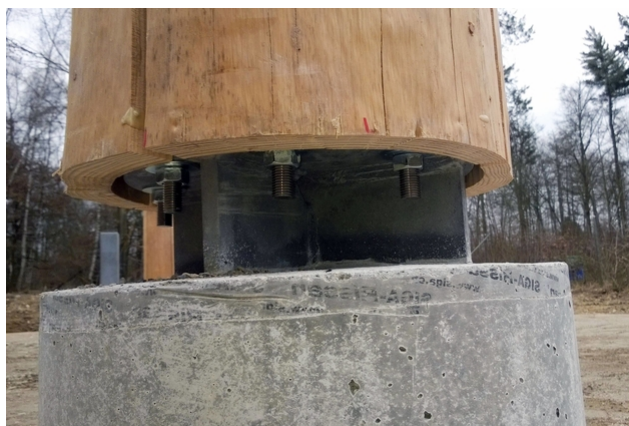
Montierter Stützenfuss
