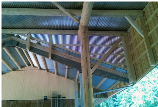
Tragwerk im fertigen Gebäude
