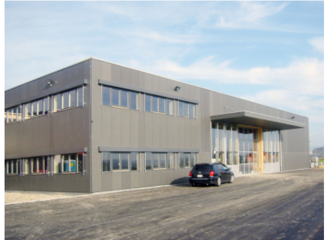
Gebäudeschmalseite mit 3m Vordach
