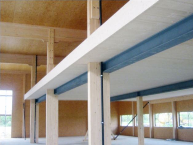
Galerie mit 1t Nutzlast pro m2
