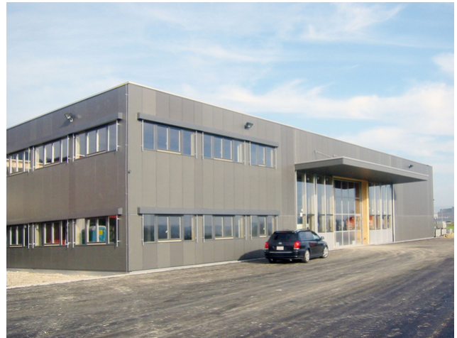
Gebäudeschmalseite mit 3m Vordach
