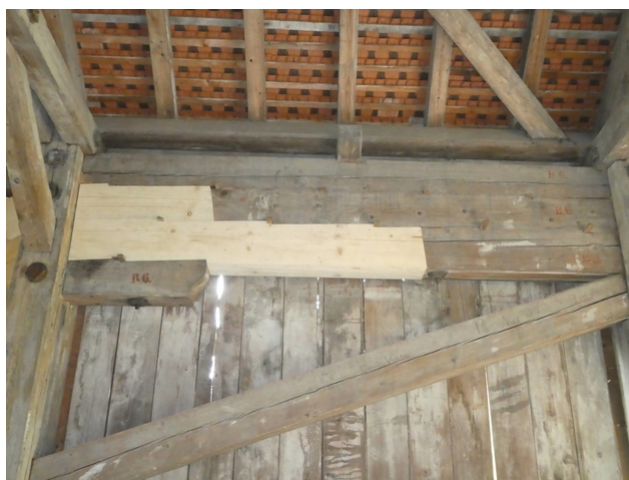
Bestehendes und saniertes Tragwerk
