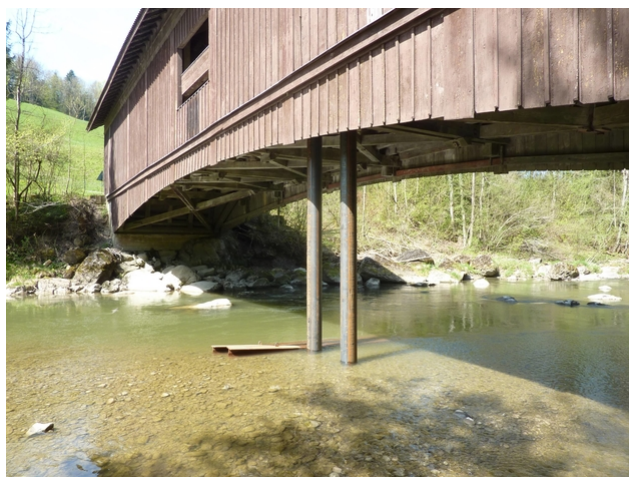
Provisorische Rammpfähle zur Stabilisierung
