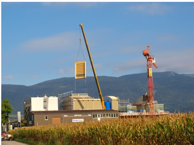
Montage Aussenwände
