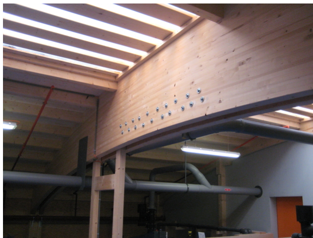
Zusammenschluss Dachschalen
