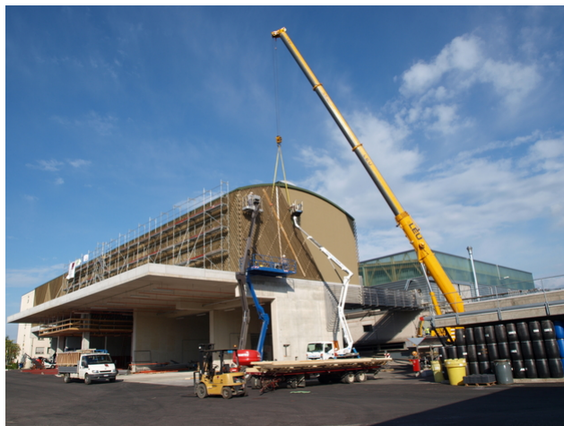
Montage Fassadenelemente
