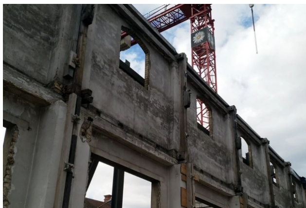
Das Gebäude wurde bis auf seine Fassade rückgebaut.
